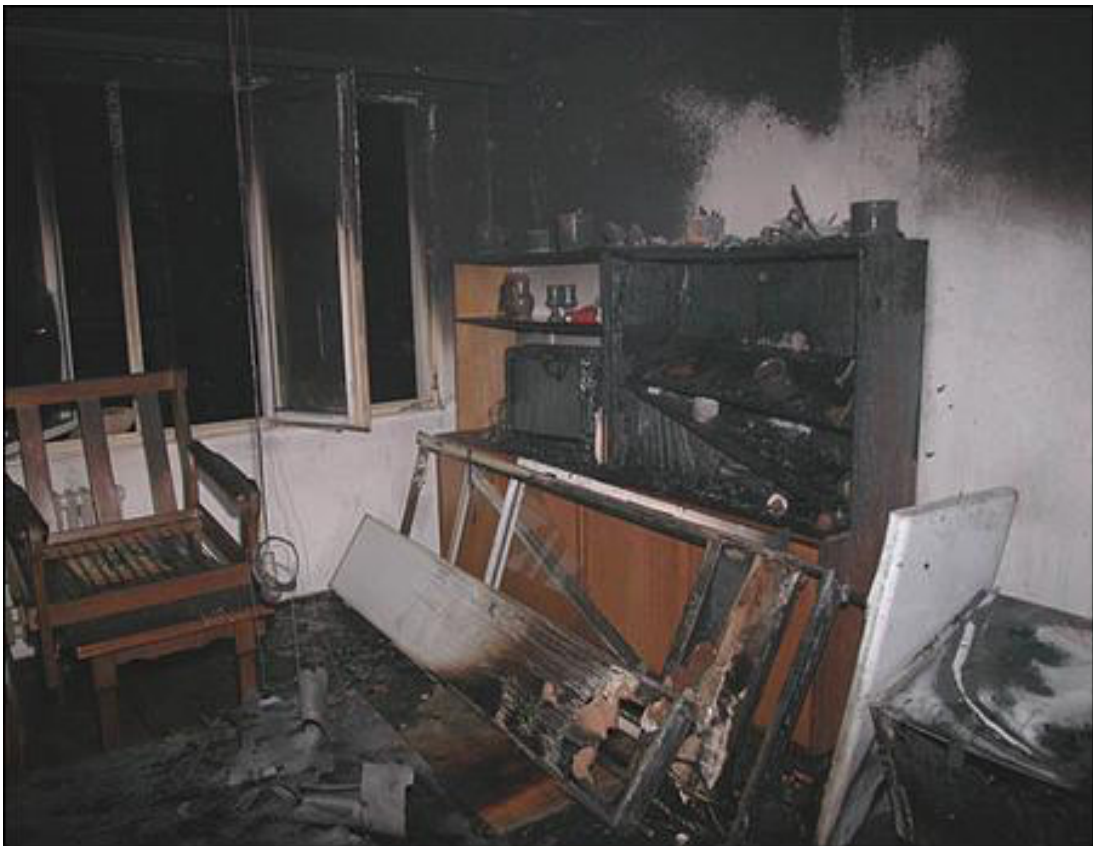
Obr. 3 – Byt po požáru se stopami pyrolýzy v horní části místnosti a na horních plochách nábytku (foto převzato z www.pozary.cz )
